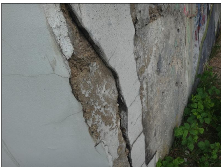
Trhliny v povrchu křídla a jeho následná degradace
