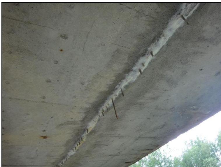
Výluhy pojiva s inkrustací ve spárách mezi nosníky v krajních oblastech
