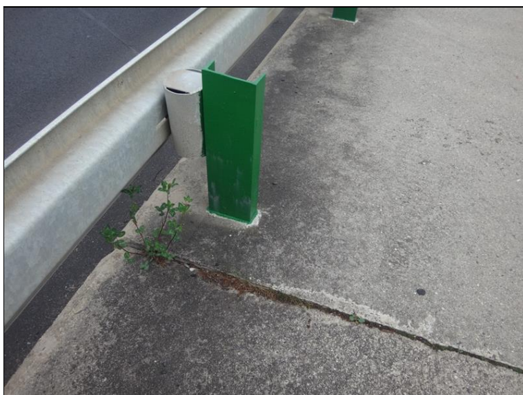
Úchyt vegetace ve spárách na římse
