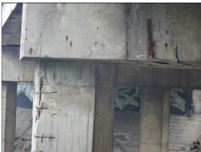
Poruchy na vnitřních podpěrách
