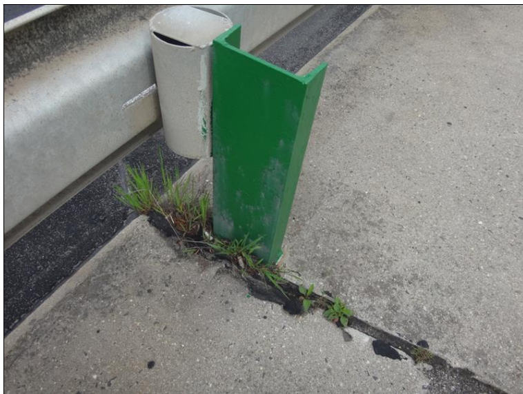
Úchyt vegetace ve spárách na římse, poruchy těsnění spár na řimsách
