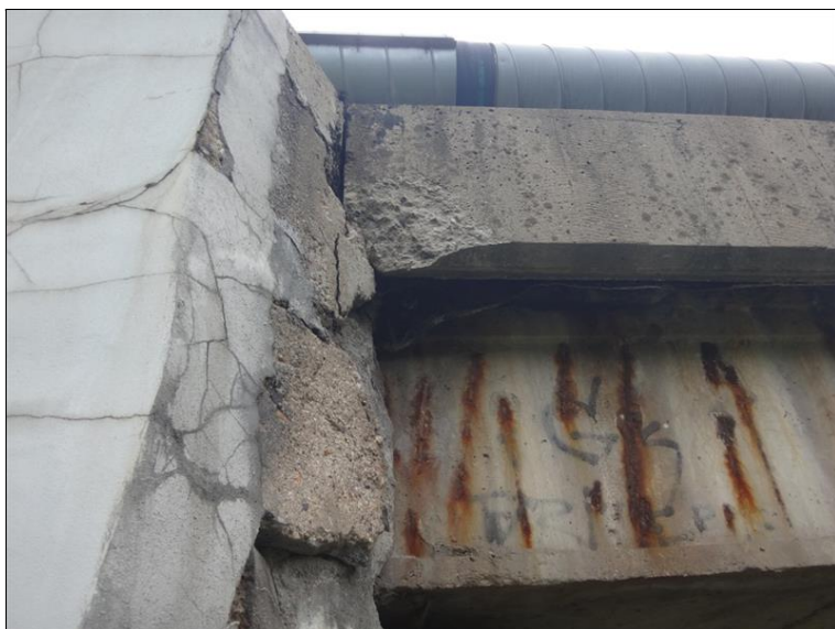
Detail konce NK na podpěře 4 vlevo, trhliny v povrchu křídla
