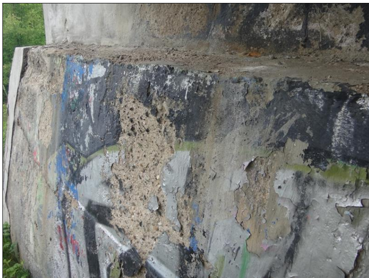
Degradace povrchu na podpěře 4
