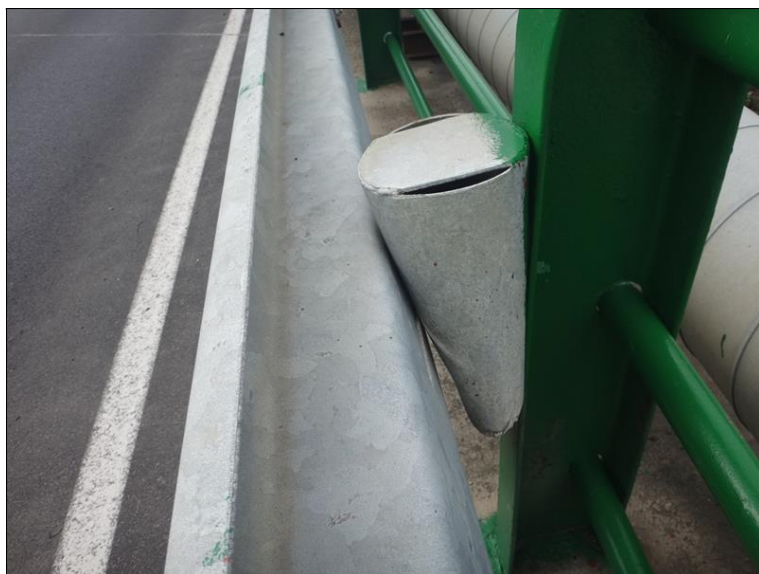
Deformace svodidel vlevo
