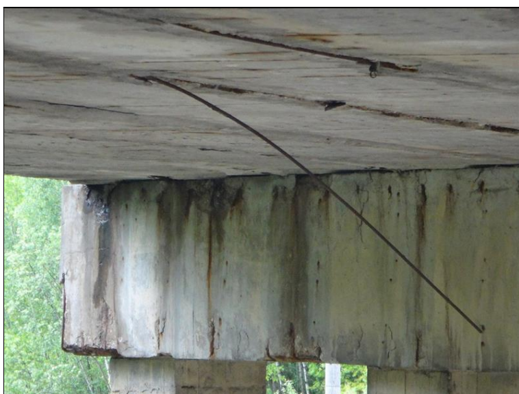
Podhled NK a pohled na čelo stativa na podpěře 3 s projevy zatékání
